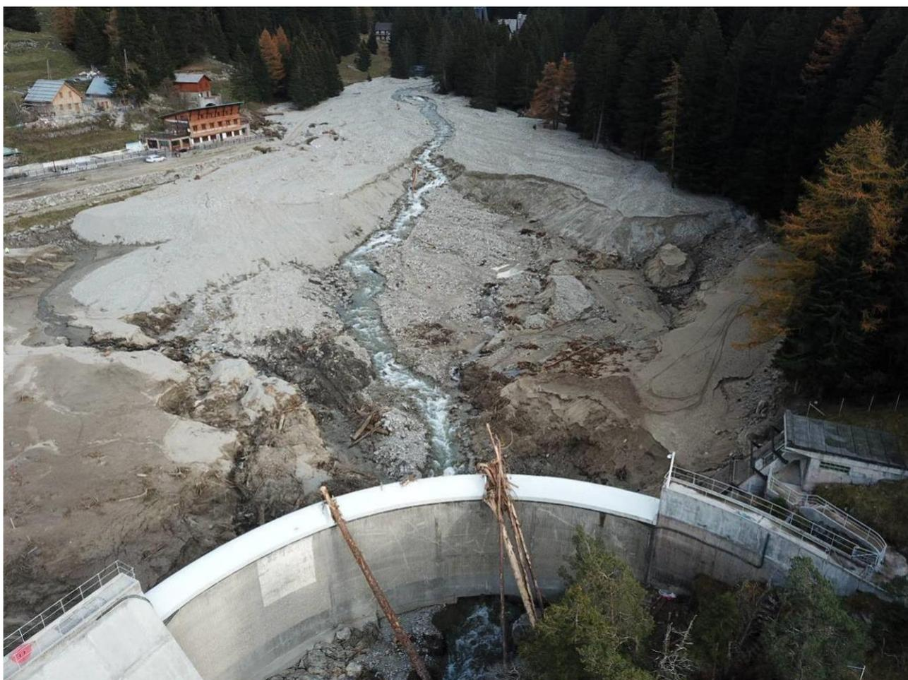
**Figure 4 : Dépôt massif en amont du barrage.**
